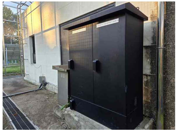
손상내용 검수실 외부 전기설비 상태양호 손상원인 -
