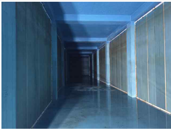
배수지 1지 내부 전경
