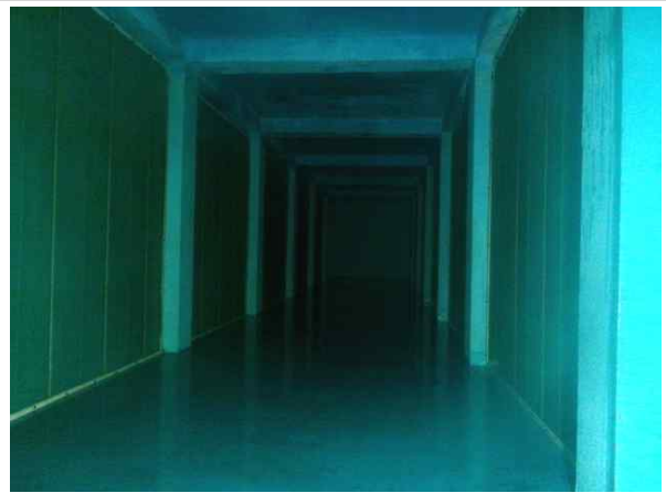
배수지 2지 내부 전경
