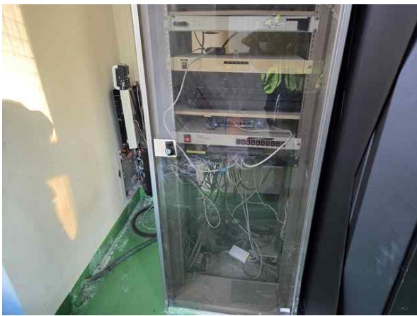
손상내용 전기실 전기설비 상태양호 손상원인 -
