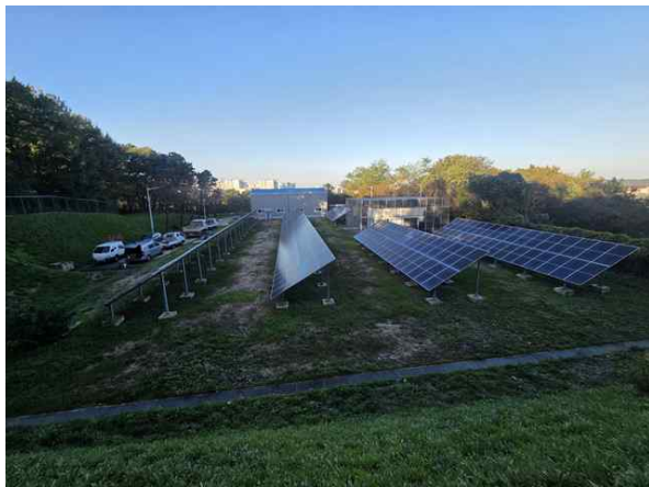
배수지 상부 현황
